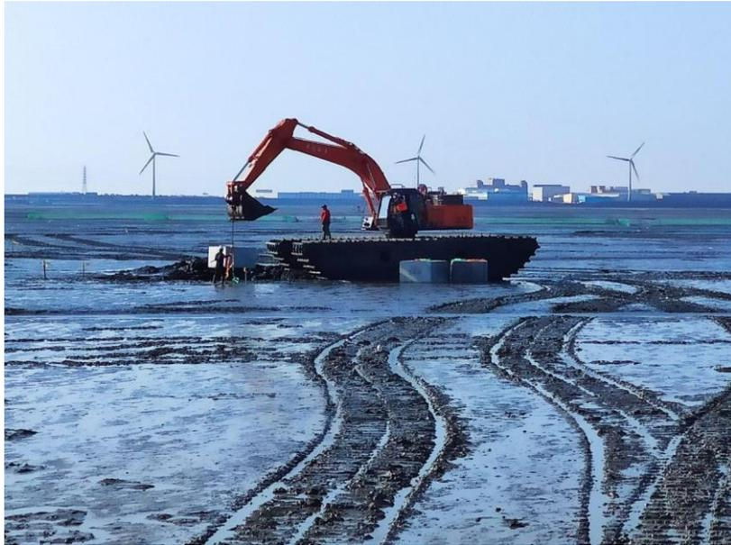
混凝土錨係用以限制浮筒的移動。混凝土錨的設計均考量土壤條件，同時經由定期的強度檢查進行驗證。根據為本專案準備的大地工程調查報告，預定的浮力式太陽能模組發電區內的基層土包括微砂土壤、細砂和粘土。
